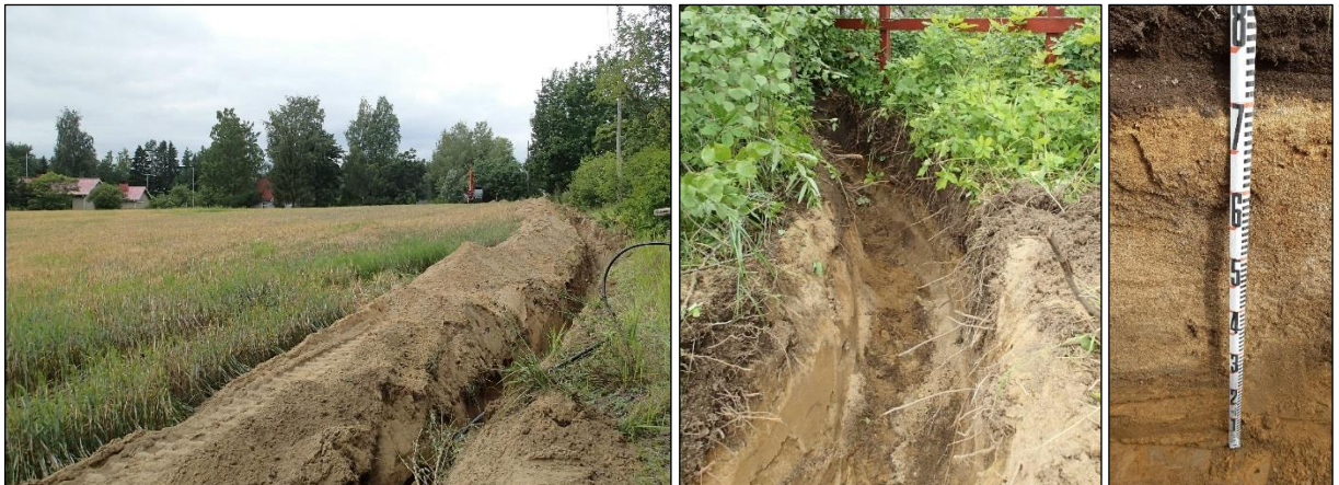
Vasen. Kaivettua kaapeliuraa peltoalueen länsilaidalla. Kuva luoteeseen. Keskellä ja oikealla. Kaapeli- kaivantoa pellon pohjoisosassa.
