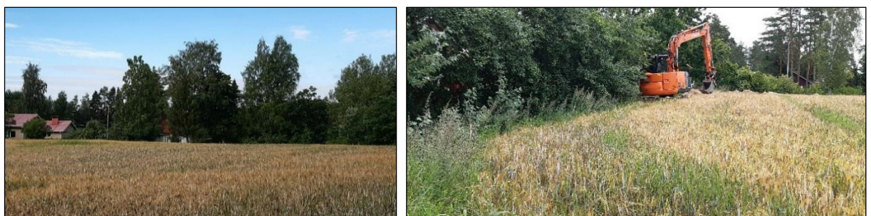
Vasen. Kaapelilinjan reitti kulkee pellon reunassa, kuva kaakkoon. Oikea. ojaa kaivetaan pellon reunaan, kuva pohjoiseen.
