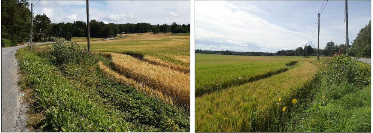
Kaapelilinjan reittiä Salonsaarentien kaakkoispuolella pellon reunalla, vasemmalla kuvattuna pohjois-koilliseen ja oikealla kuvattuna etelä-kaakkoon.
