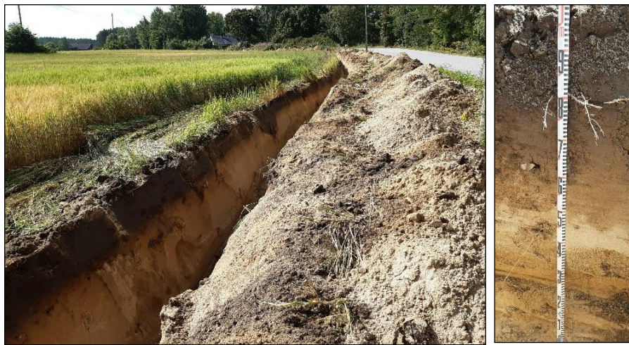
Kaivettua kaapeliojaa Salonsaarentien kaakkoislaidalla, kuva lounaaseen.
